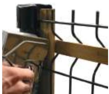
**IV.** Insérez les lattes de remplissage pour finaliser votre kit. Veilliez à les agrafez une à une sur les renforts trapezoïdaux.
